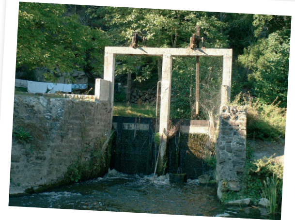
Barrage du pont, à Saint-Cénéri-le-Géréi (61)
