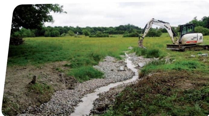
*Travaux de recharge de granulat pour diversifier les écoulements et favoriser l'auto-curage.*
