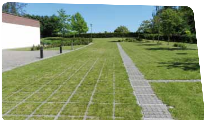
Une aire de stationnement végétalisée permet l'infiltration des eaux de pluie.
