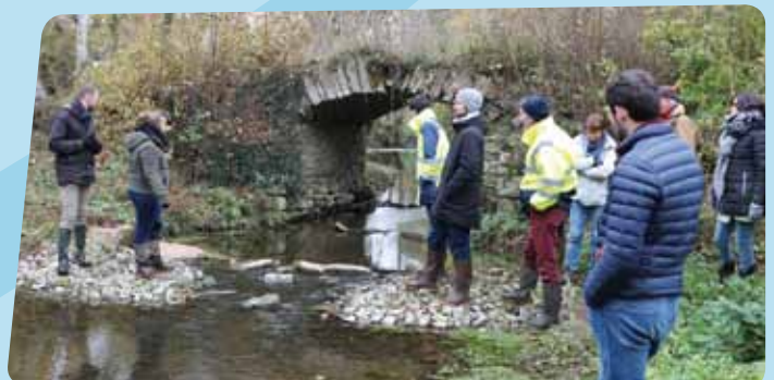
Visite du chantier du Treulon le 20 novembre 2018.
