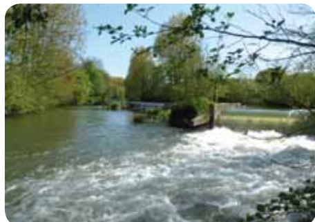
Le seuil sur l'Huisne avant les travaux.
