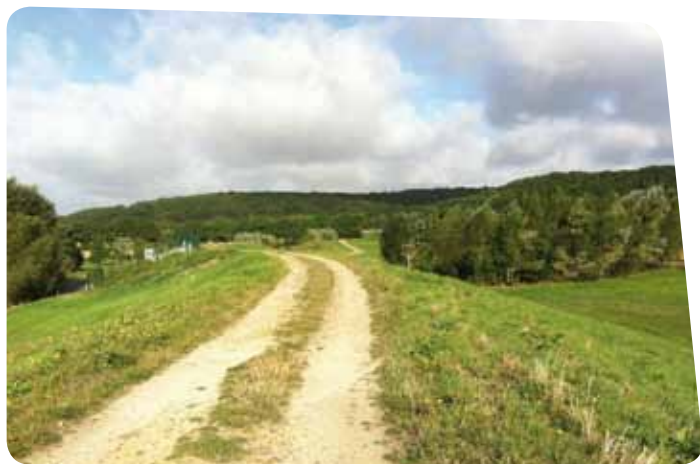
Retenue d'écrêtement des crues de Margon, vue depuis la crête.
