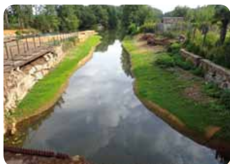
Le bief du moulin après travaux.
