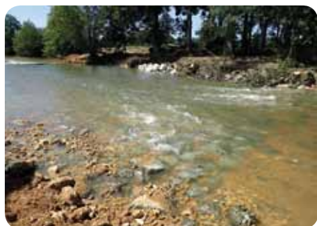
L'Huisne après les travaux.
