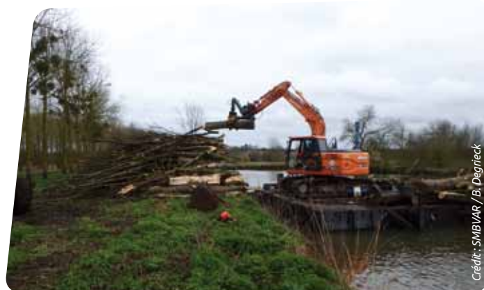
Travaux menés sur les îles du Moulin d'Ivray sur la Sarthe à Tiercé.
