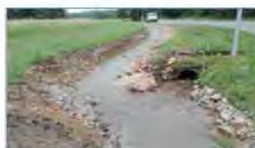
Figure 29: Photographies de restauration morphologique de type R3 sur le ruisseau de Belnoë (à gauche : reméandrage) et sur le ruisseau de Saint-Loup (à droite : remise dans le talweg) source : Syndicat de la Haute Sarthe – CdC du Pays de Mortagne-au-Perche
