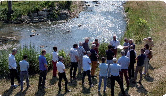
Les membres du Comité de pilotage visitent le chantier d'aménagement de l'ouvrage hydraulique au droit du camping du Mêle-sur-Sarthe (61)
