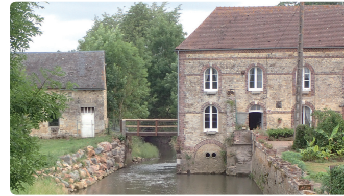
Site de restauration de la continuité écologique de la Sarthe au Moulin de Longpont à La Mesnière (61), en aval immédiat de la confluence avec l'Hoëne.
