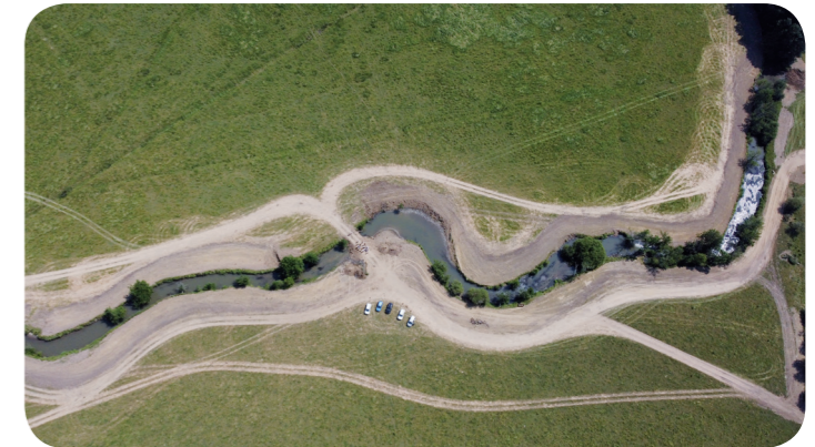
Site d'arasement de merlons de curage sur 960 ml (en rive droite et en rive gauche), réalisé par le Syndicat de Bassin de la Haute Sarthe.
