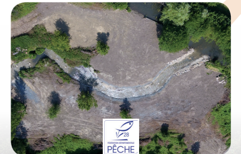
La Rhône (Nogent-le-Rotrou - 28) après travaux.
