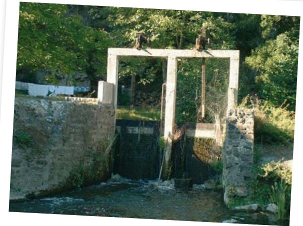
Barrage du pont, à Saint-Cénéri-le-Géréi (61)
