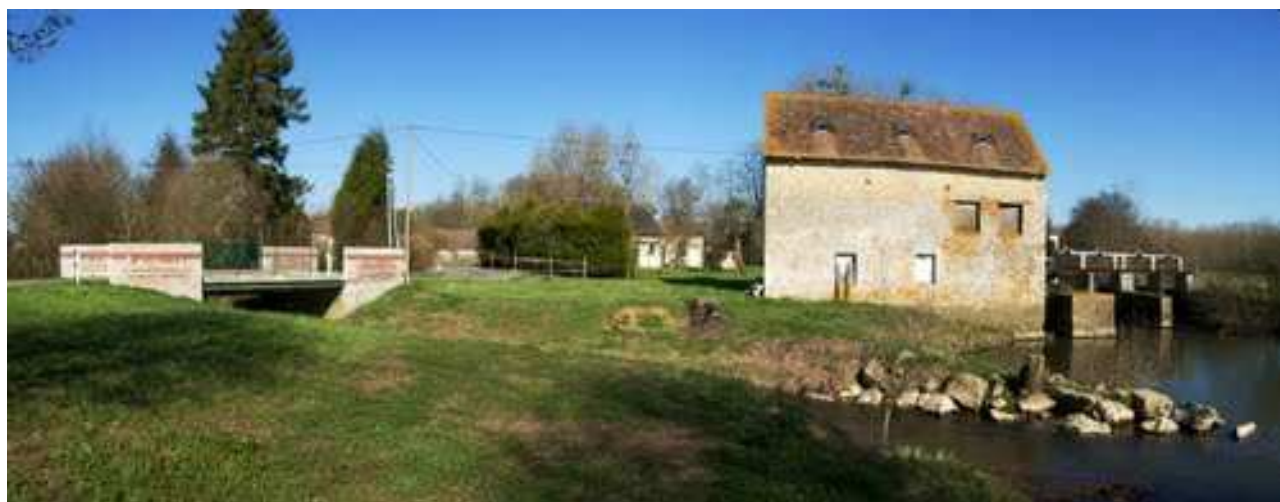
Moulin de Ménil-Broût © Dutour
